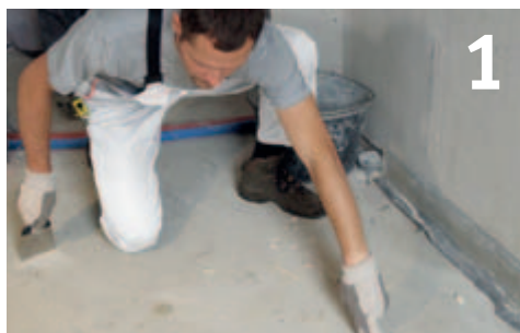
1 wyczyścić podłoże i usunąć ewentualne nierówności
