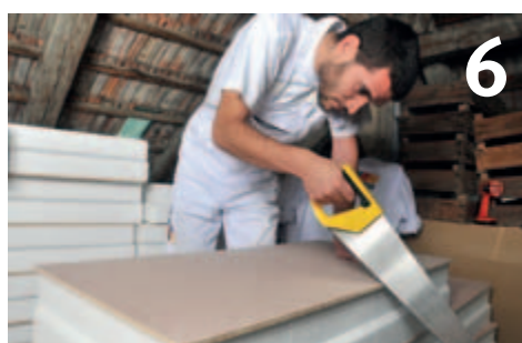
6 dociąć płyty Padlap
