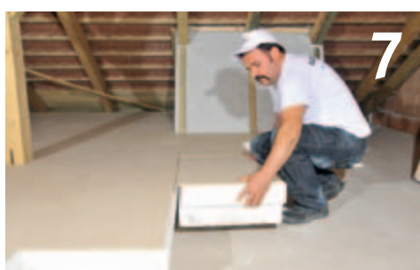
7 rozłożyć płyty Padlap
